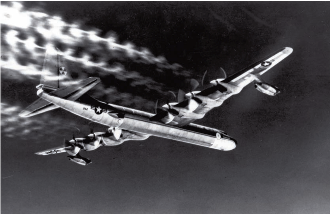
Die NB-36H im Flug. Das Warnzeichen am Leitwerk für den fliegenden Kernreaktor ist deutlich sichtbar.
